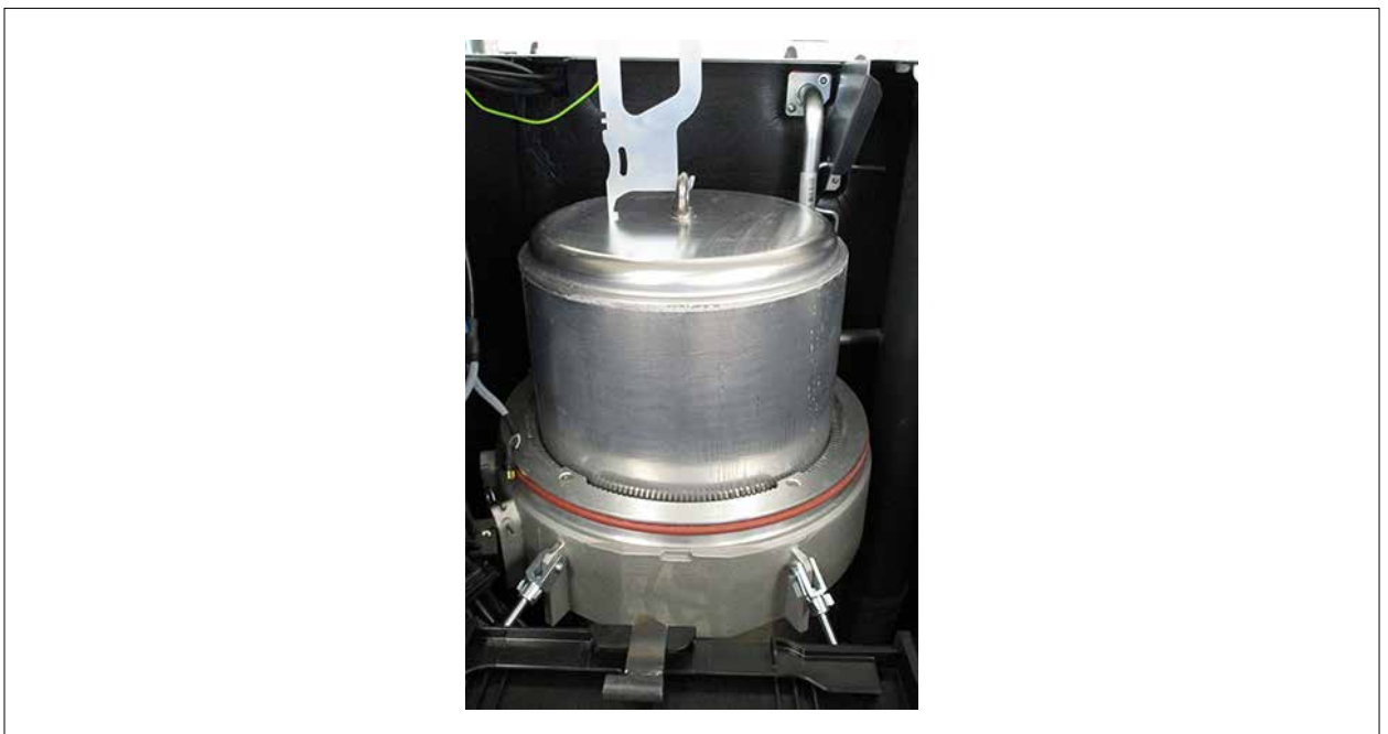
Abb. 5.18 Unteren Verdränger herausziehen
